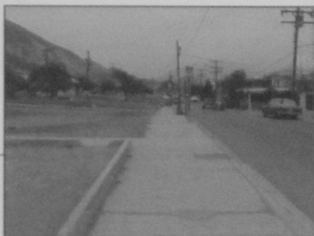
PARQUE VISTA MONTAÑA E. ZAPATA Y N. ZAMBRANO Instalación de defensa metálica
